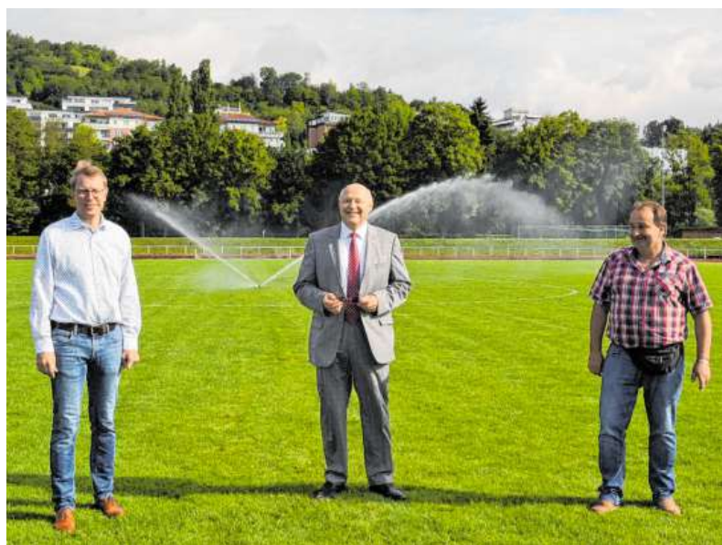
OB Udo Glatthaar (Mitte), Sportamtsleiter Kersten Hahn (links) und Bauhof-Chef Georg Teufel machten sich ein Bild von der neuen Beregnungsanlage im Deutschorden-Stadion.
