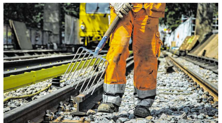
Gleisbauer arbeiten an den Verkehrswegen von morgen: Durch die wirtschaftlichen Folgen der Corona-Pandemie könnten wichtige Zukunftsinvestitionen auf der Strecke bleiben, warnt die Gewerkschaft IG Bau.
